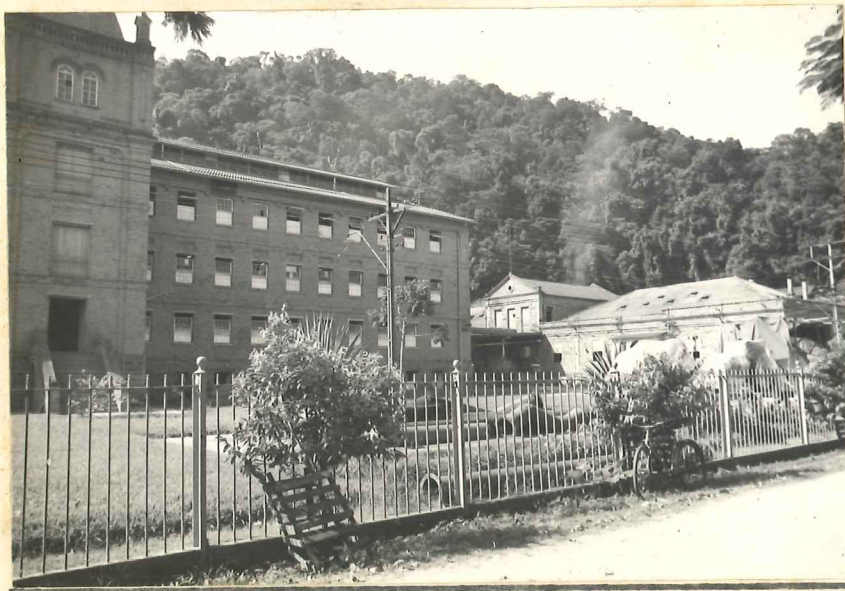
Vista do prédio principal com o anexo de construção posterior em alvenaria de pedra.
